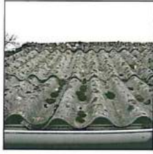
Welleternit und Wellbitumenplatten
